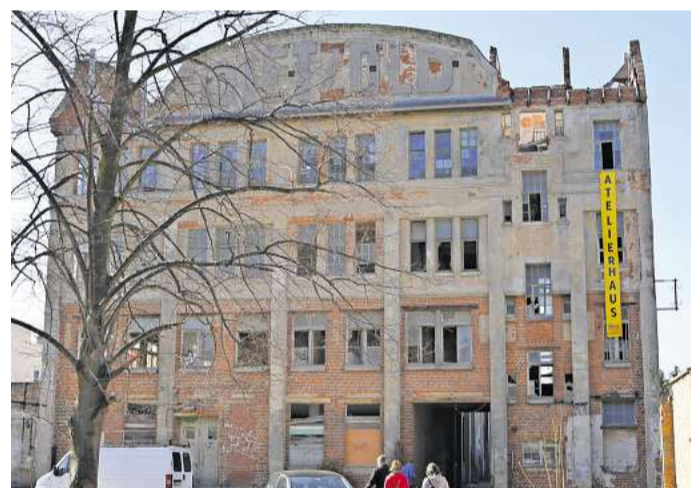
links: Das ehemalige Dietzold-Werk in Leipzig-Leutzsch wird derzeit zu einem Atelierhaus umgestaltet. rechts: Eine niederländische Künstlergruppe baut aus Materialien, die sie in Abrisshäusern findet, Kunstwerke. Eins davon hängt im Dietzold-Werk. Foto: Dirk Knofe
